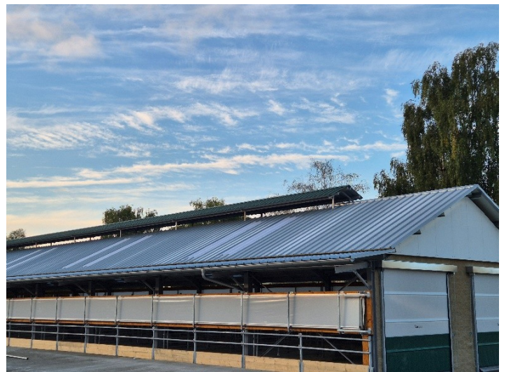
Obrázok 2: Rekonštrukcia ustajnenia teliat (teľatník)
