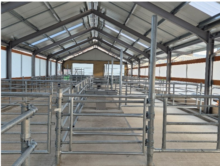
Obrázok 1: Rekonštrukcia ustajnenia teliat (teľatník)
